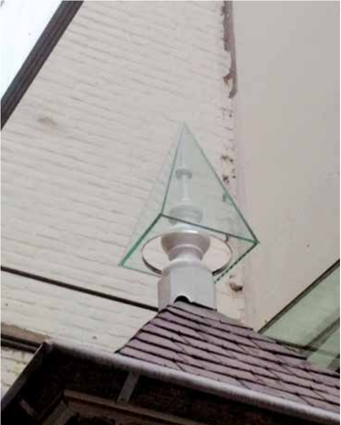
PROJECT Klooster - Tilburg PRODUCT UV verlijmd kap
