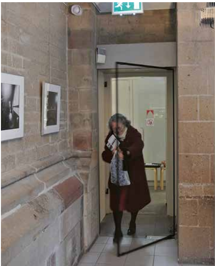
PROJECT DOM Utrecht PRODUCT scc SYSTEMS FIRE DOOR LUNAX EW 30™ / 60™ ONTWERPER van Hoogevest architecten Amersfoort
